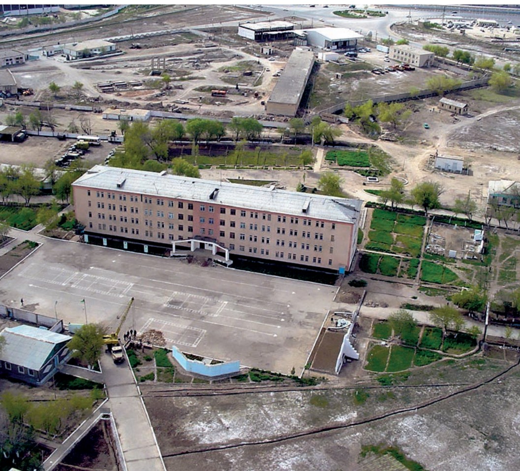
Штаб и казарма 17-го Марьинского авиационного полка ПВ КГБ СССР
