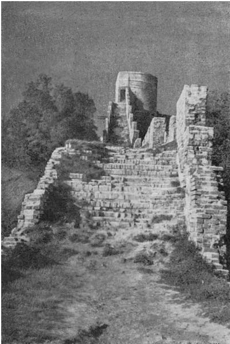
24. Лестница по боевому ходу стеньк Часовой башне до реставрации
