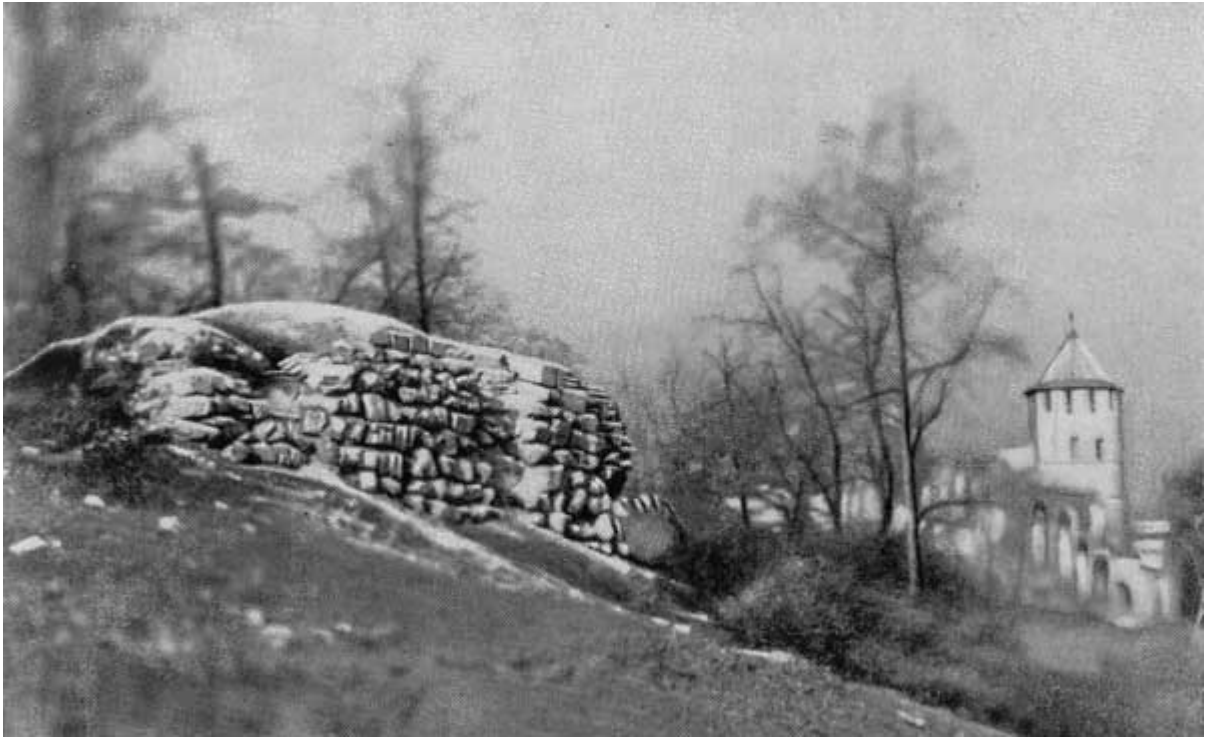
49. Подгорный участок крепля до реставрации.1947 г.
