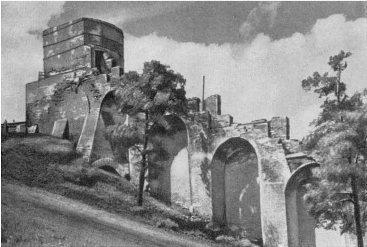
51. Часовая башня до реставрации.1952 г.
