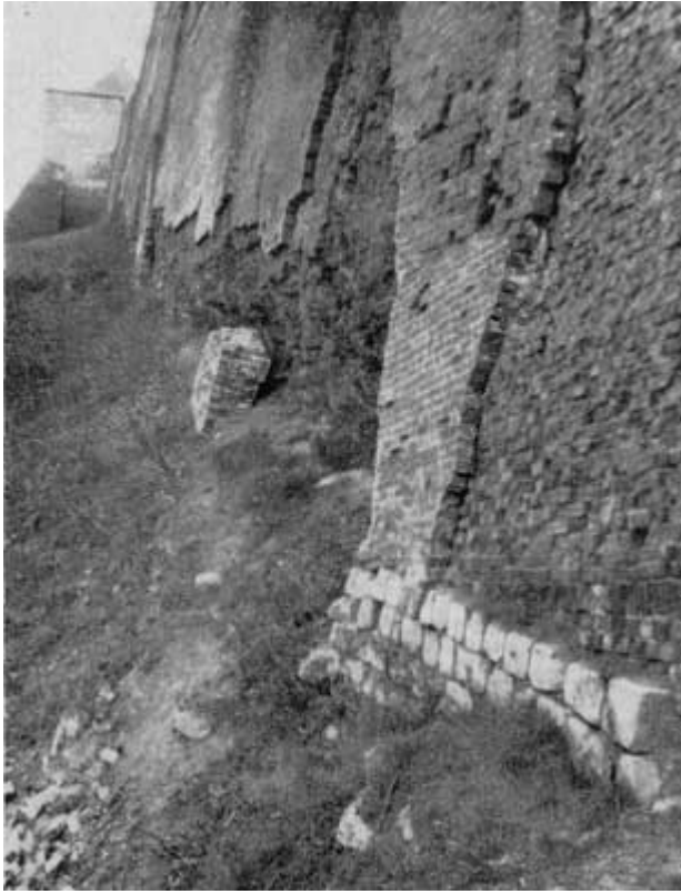
47. Разрушение кладки нижней части стены на прясле Георгиевская — Борисоглебская. 1952 г.
