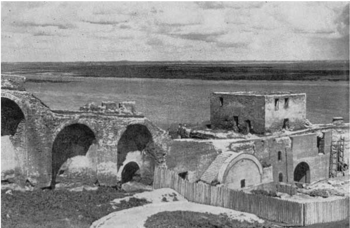
40. Ивановская башня, начало реставрационных работ 1952 г.
