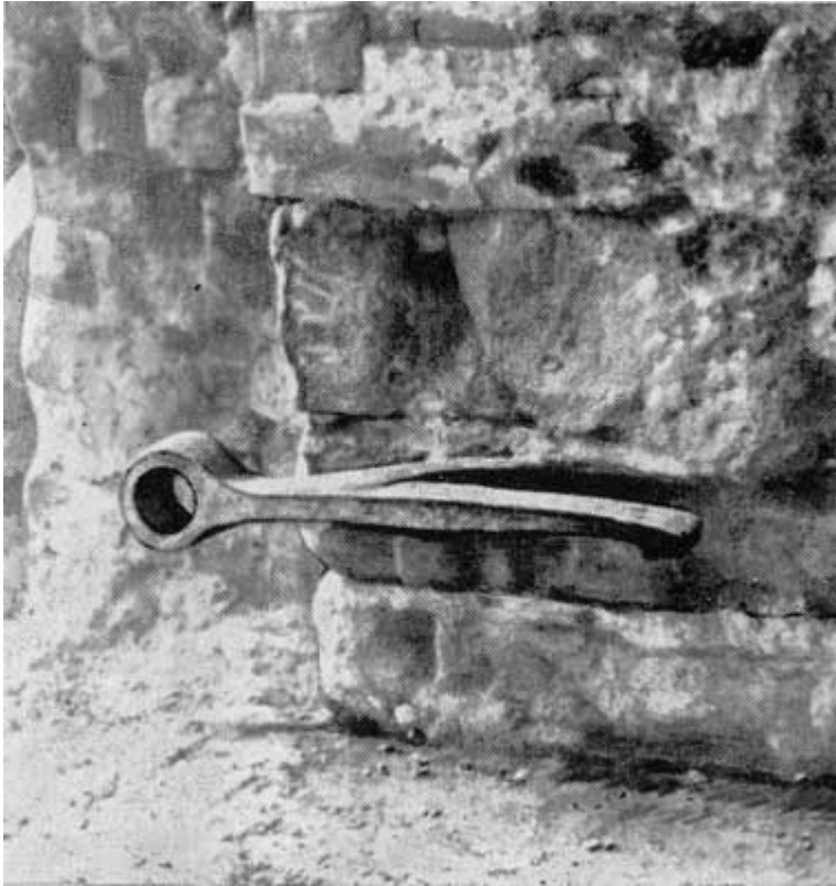
36. Никольская башня. Прошина нижней оси подъемного моста. 1960 г.
