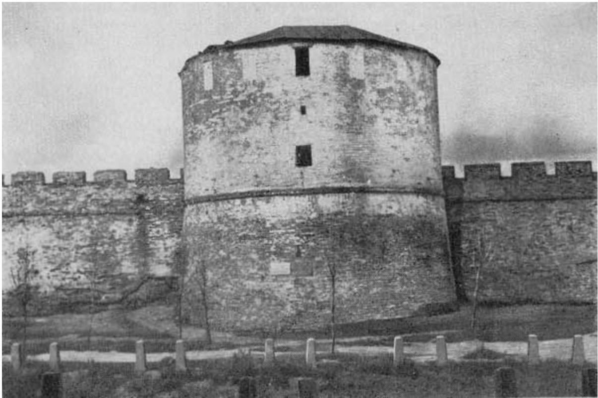
23. Кладовая башня до реставрации, 1950 г.
