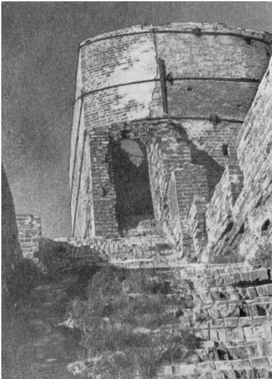
52. Верх Часовой башни до реставрации.1952 г.
